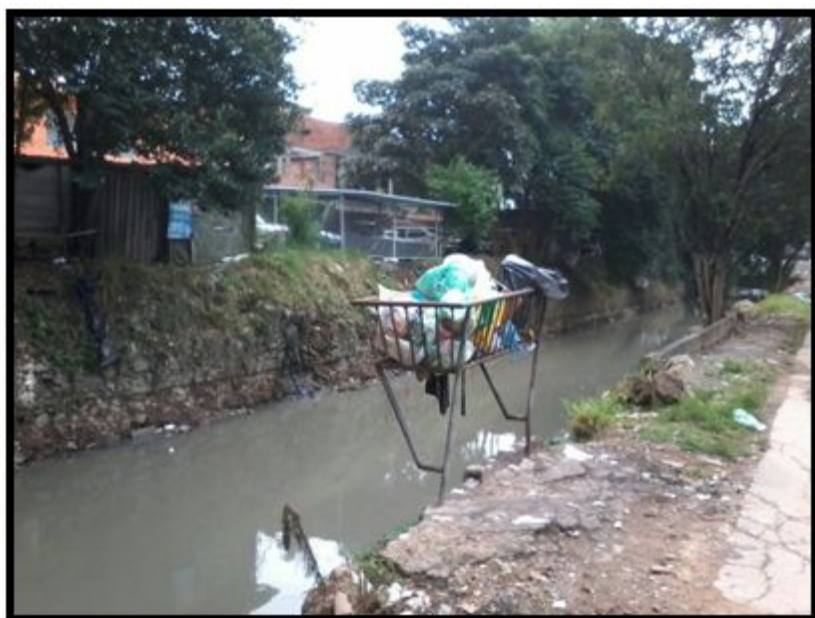
Figura 12: Suporte para lixo sobre o córrego Moenda Velha (Fonte: Arquivo Pessoal, 2015).
