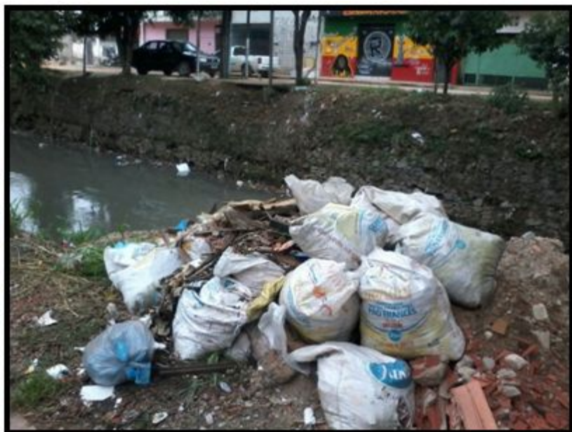
Figura 11: Depósitos de lixo no córrego Moenda Velha (Fonte: Arquivo Pessoal, 2015).
